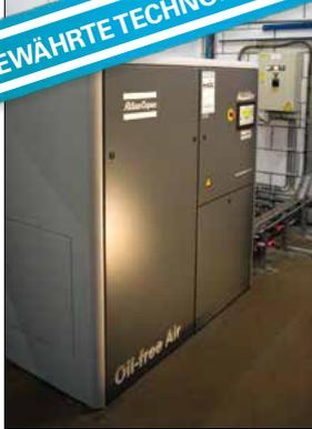
Im AQ befindet sich ein einzigartiges Schraubenelement mit Wassereinspritzung für eine hocheffiziente, nahezu isothermische Kompression.
